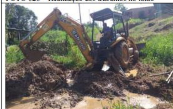
FOTO 028 – Manutenção abertura de canal
