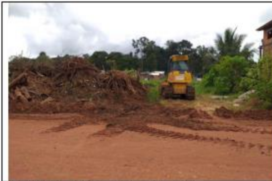
FOTO 022 – Retirada de entulho de terra
