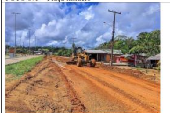
FOTO 075 – Manutenção na rua de acesso para
