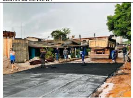
FOTO 060 – Continuação dos trabalhos
