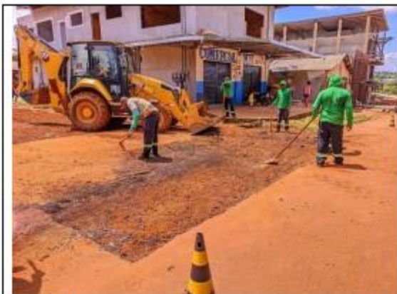
FOTO 069 – Serviços de requalificação nas ruas e avenidas
