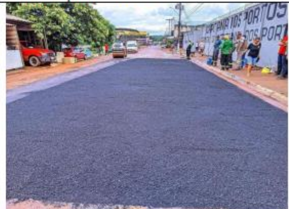
FOTO 066 - Recuperação das vias e serviço de recapeamento.
