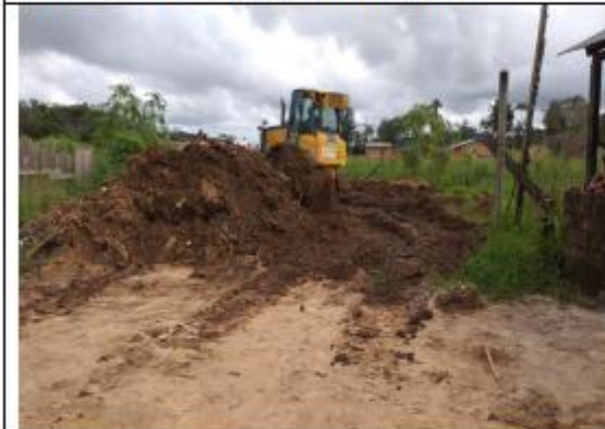
FOTO 024 - Retirada de entulho de terra
