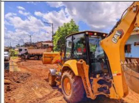
FOTO 067 – Realização dos serviços para melhorias das ruas
