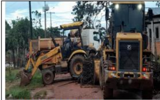
FOTO 030 – Retirada de Entulho
