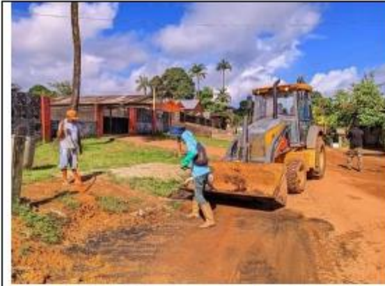
FOTO 051 - Retirada de Entulhos Bairro Nova Esperança município de Oiapoque
