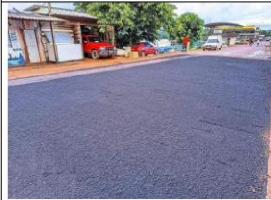
FOTO 065 - Serviços executados pela empresa CNN
