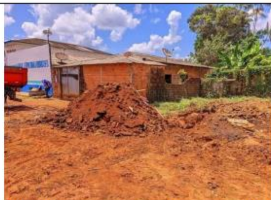
FOTO 070 - Serviços de requalificação nas ruas e avenidas
