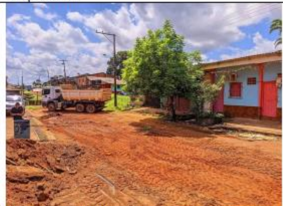
FOTO 068 – Realização dos serviços por empresa terceirizada
