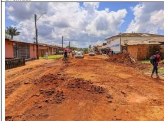
FOTO 071- Serviços de requalificação nas ruas e avenidas
