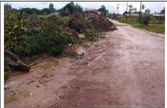
FOTO 023 – Retirada de entulho de terra
