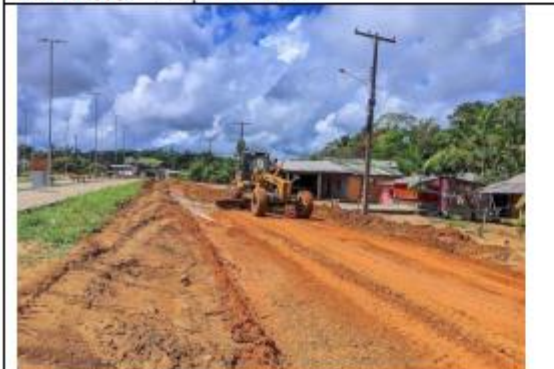
FOTO 075 – Manutenção na rua de acesso para
