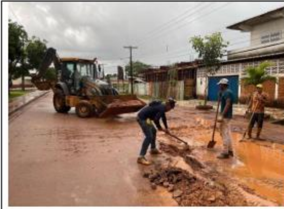
FOTO 063 – Realização dos serviços
