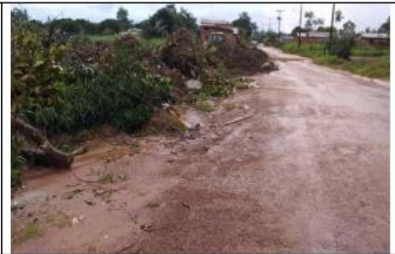
FOTO 023 – Retirada de entulho de terra
