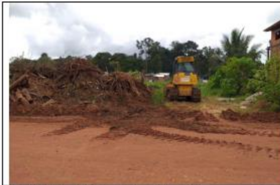
FOTO 022 – Retirada de entulho de terra
