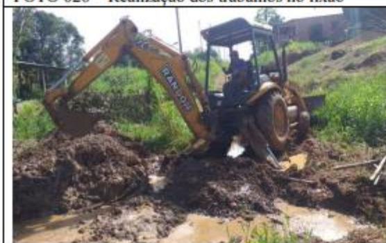
FOTO 028 – Manutenção abertura de canal
