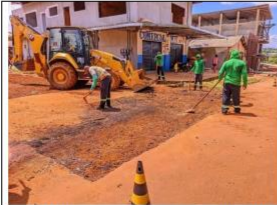
FOTO 069 – Serviços de requalificação nas ruas e avenidas
