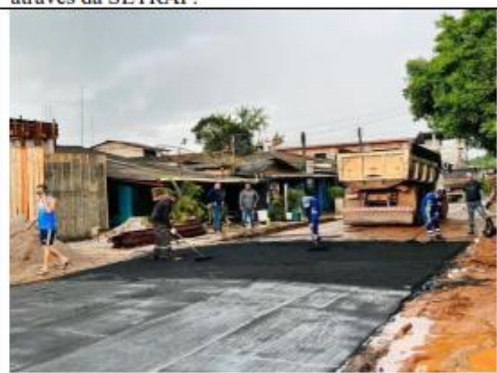
FOTO 060 – Continuação dos trabalhos
