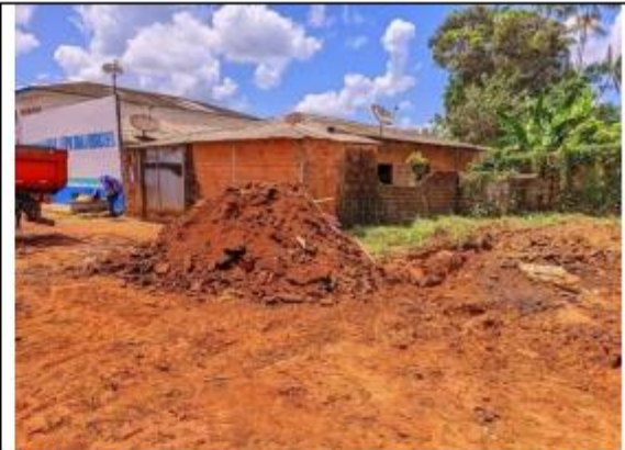
FOTO 070 - Serviços de requalificação nas ruas e avenidas
