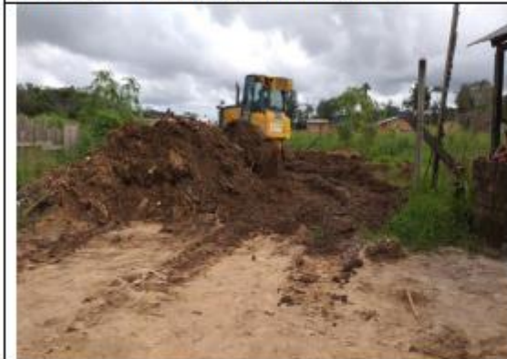
FOTO 024 - Retirada de entulho de terra
