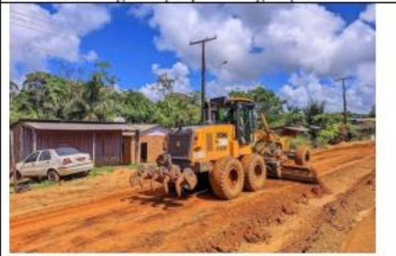
FOTO 076 - Manutenção na rua de acesso para Praça
