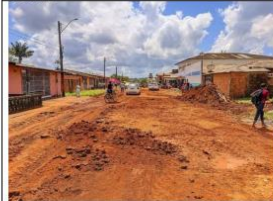
FOTO 071- Serviços de requalificação nas ruas e avenidas
