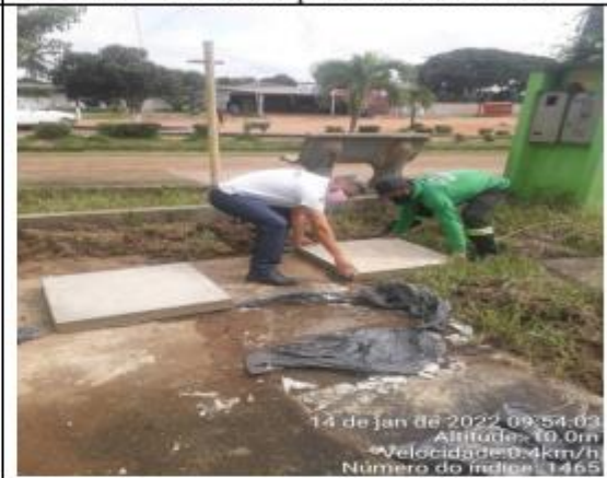
FOTO 034 – Tampa de caixa confeccionada para o terminal Rodoviário
