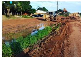
Figura 1: Manutenção das ruas do Bairro
