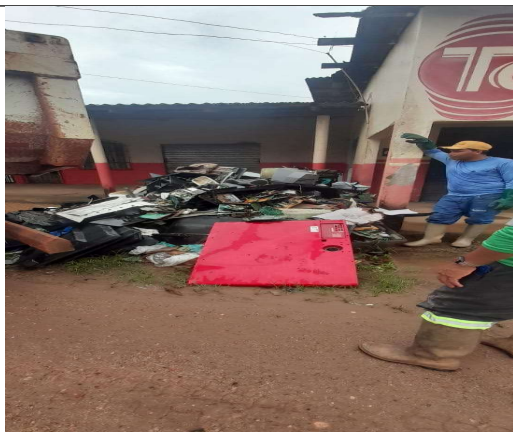
FOTO 018 - Retirada de entulho no município de Oiapoque
