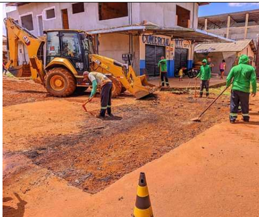
FOTO 069 - Serviços de requalificação nas ruas e avenidas
