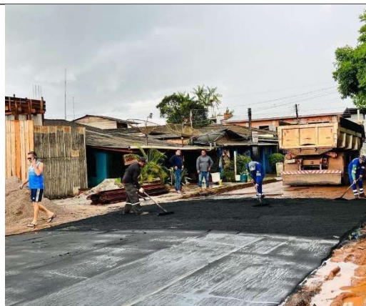
FOTO 060 – Continuação dos trabalhos
