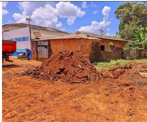
FOTO 070 - Serviços de requalificação nas ruas e avenidas
