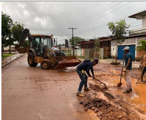
FOTO 063 – Realização dos serviços
