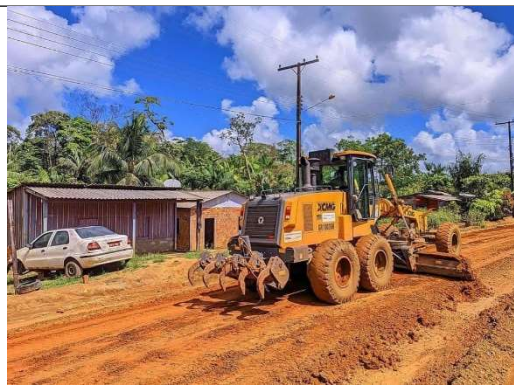
FOTO 076 - Manutenção na rua de acesso para Praça do Infraero
