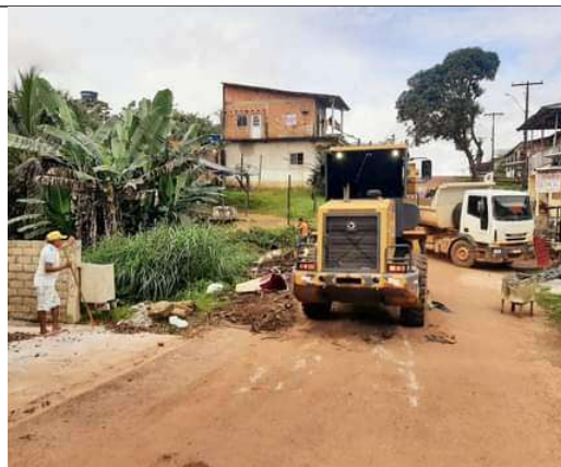
FOTO 042 – Retirada de Entulho
