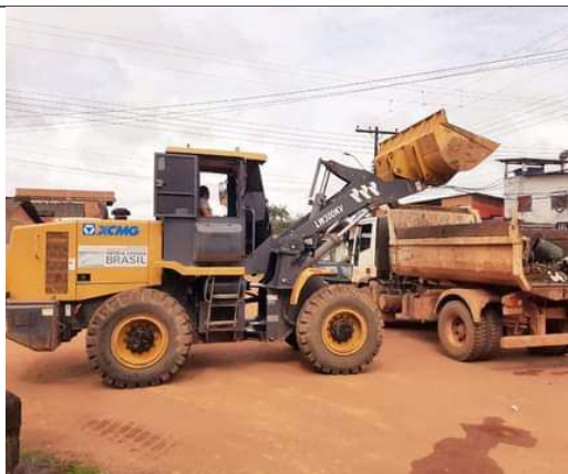
FOTO 041 – Retirada de Entulho Bairro Centro
