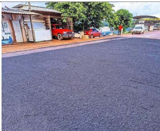
FOTO 065 - Serviços executados pela empresa CNN
