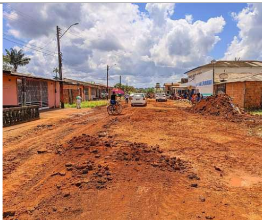
FOTO 071- Serviços de requalificação nas ruas e avenidas
