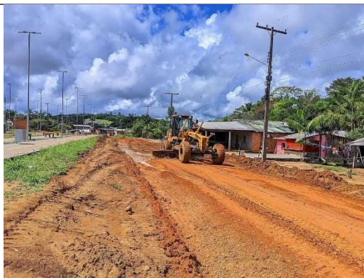
FOTO 075 – Manutenção na rua de acesso para Praça do Infraero
